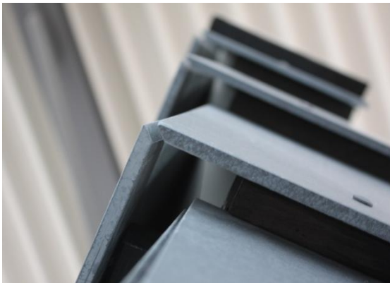
Eckdetail mit gefasteten Plattenkanten Corner detail of chamfered edges
