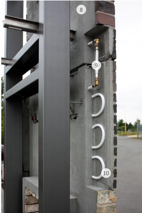
Rückansicht mit einbetonierten Rohrschlaufen Rear elevation with pipe loops encased in concrete
